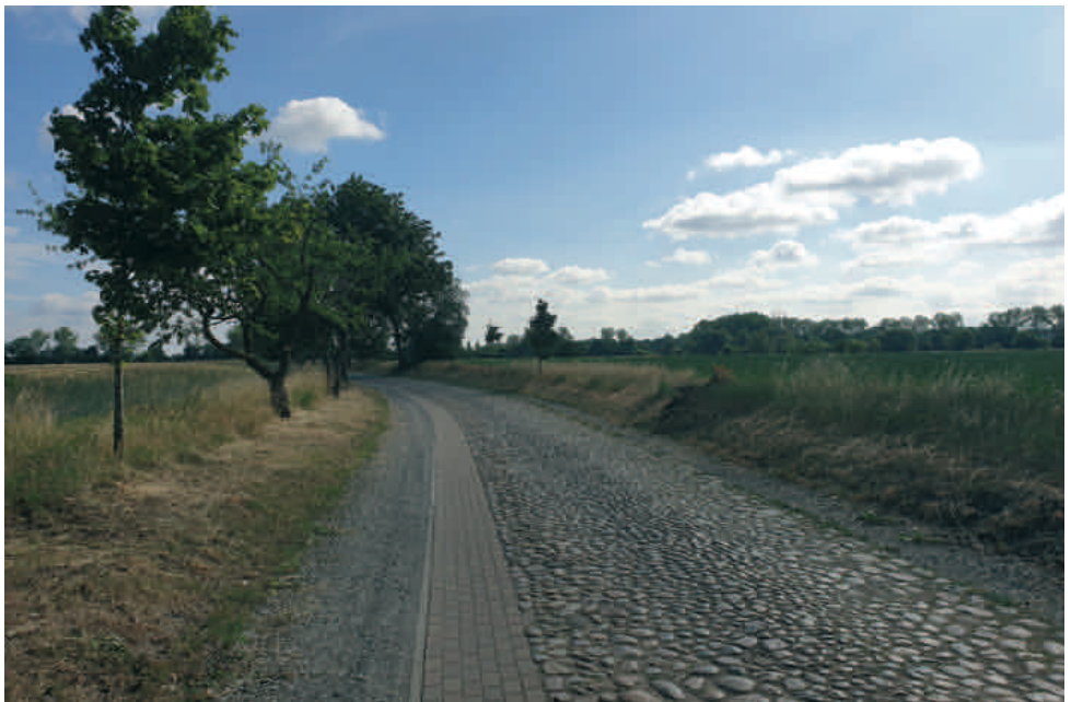
Natursteinpflaster zwischen den Dörfern
