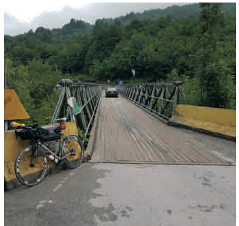
Brücke über den Fluss Piva nach der Grenze
