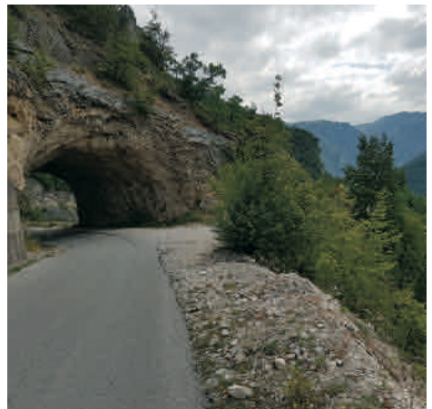
Einer der vielen kleinen Tunnel
